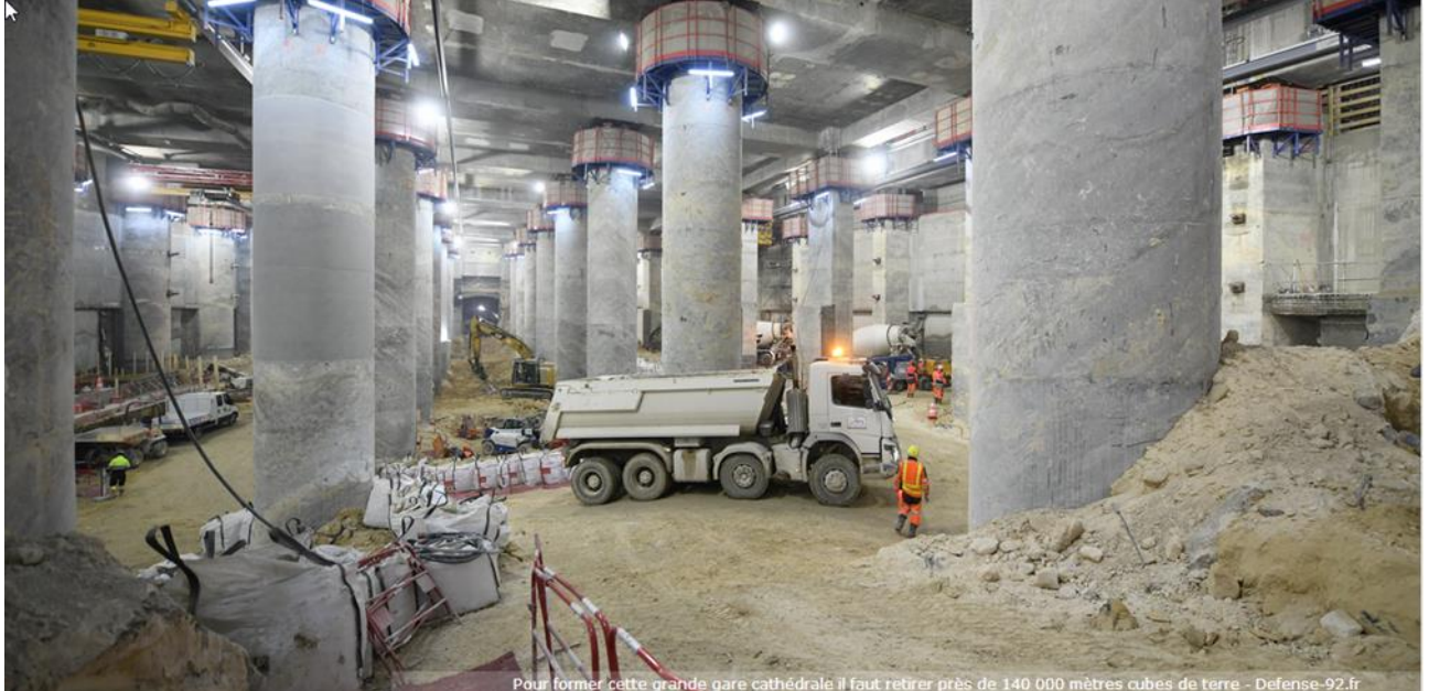
Phase finale du chantier « cathédrale souterraine » gare EOLE réalisé en sous-œuvre sous le CNIT
